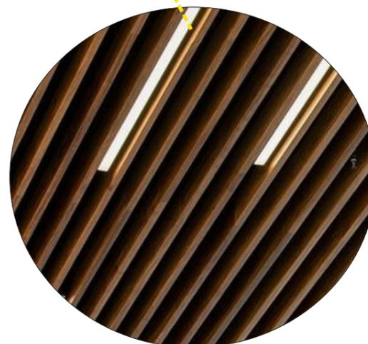
подшивка фриза и потолка ламелями из дерева с линейными светильниками между ними «желтого» света
